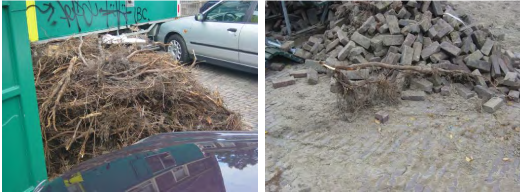
Wortelschade bij werkzaamheden, Noordermarkt
