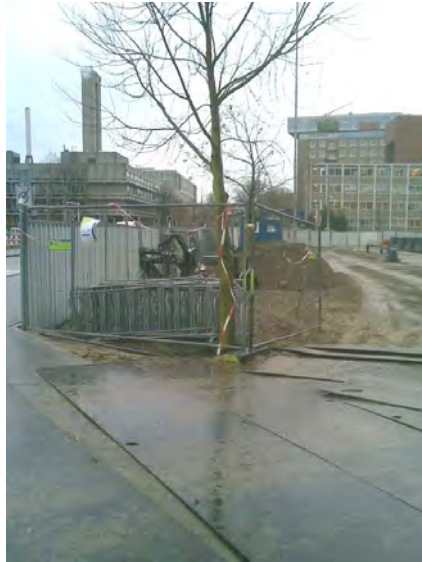
Figuur 1. Op de voorgrond boom 719 en op de achtergrond boom 720, beide op een bouwplaats.
