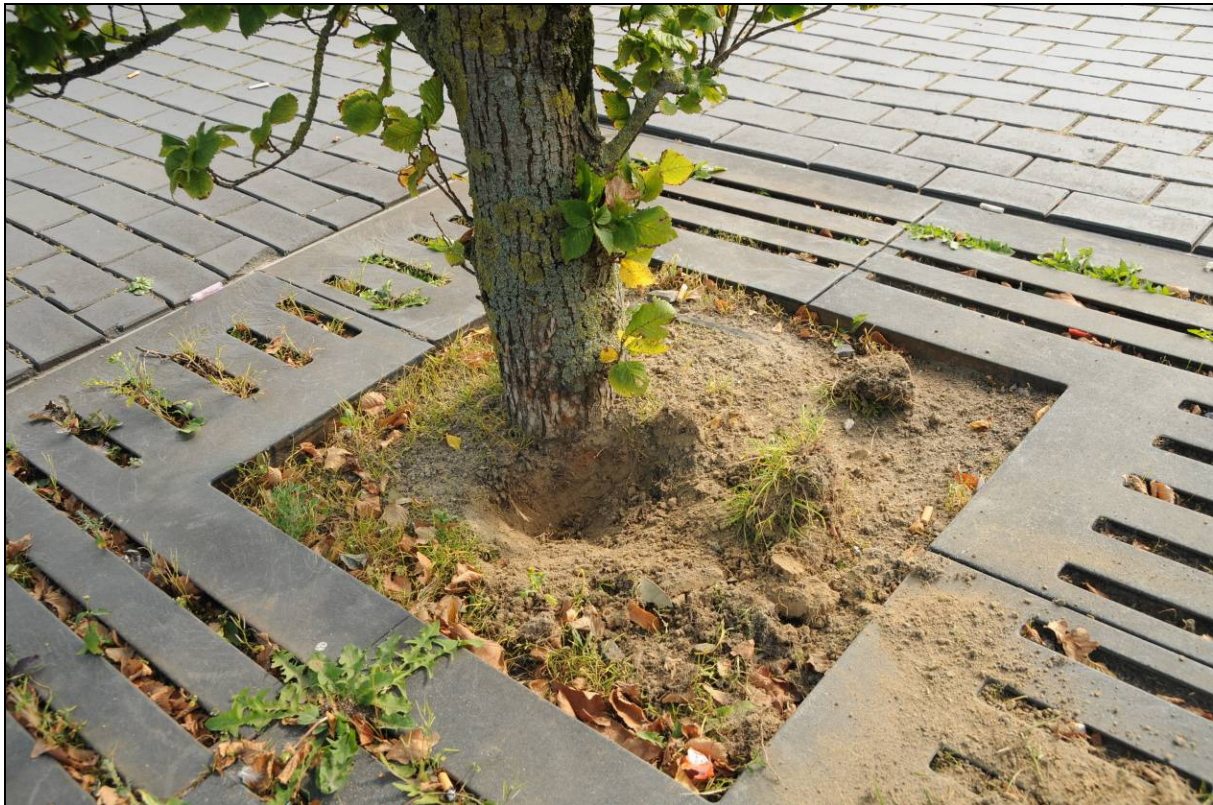
Afb. 11. Boomkluit staat overduidelijk te diep, boomspiegel fungeert als afwateringsput
