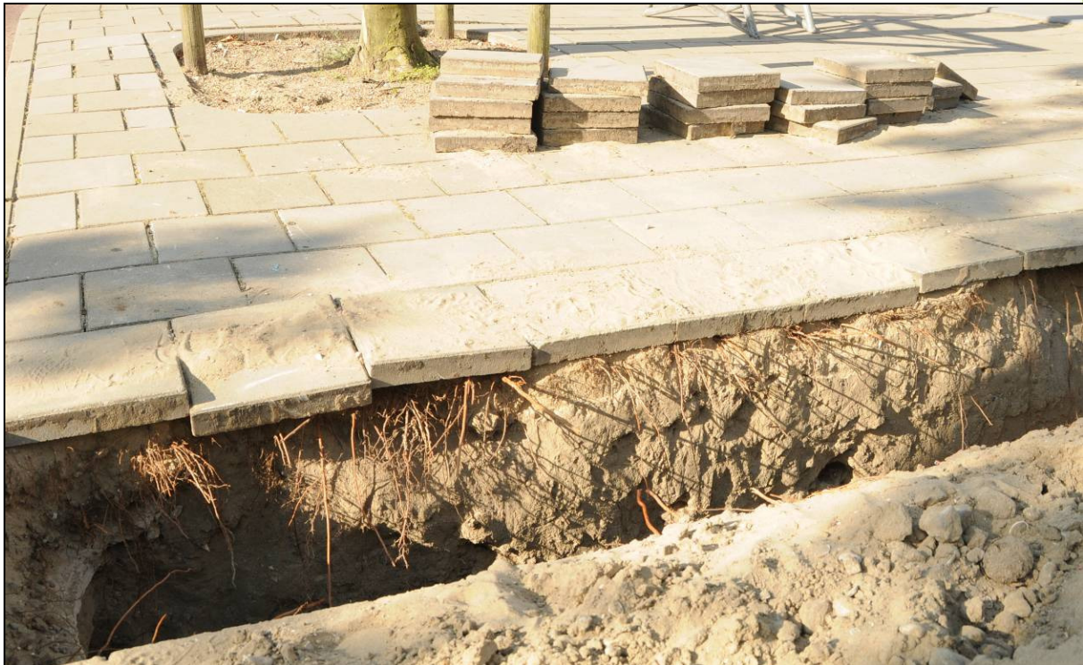
Afb.16 Boomnummer 439711 met slechts onder de bestrating fijne wortels
