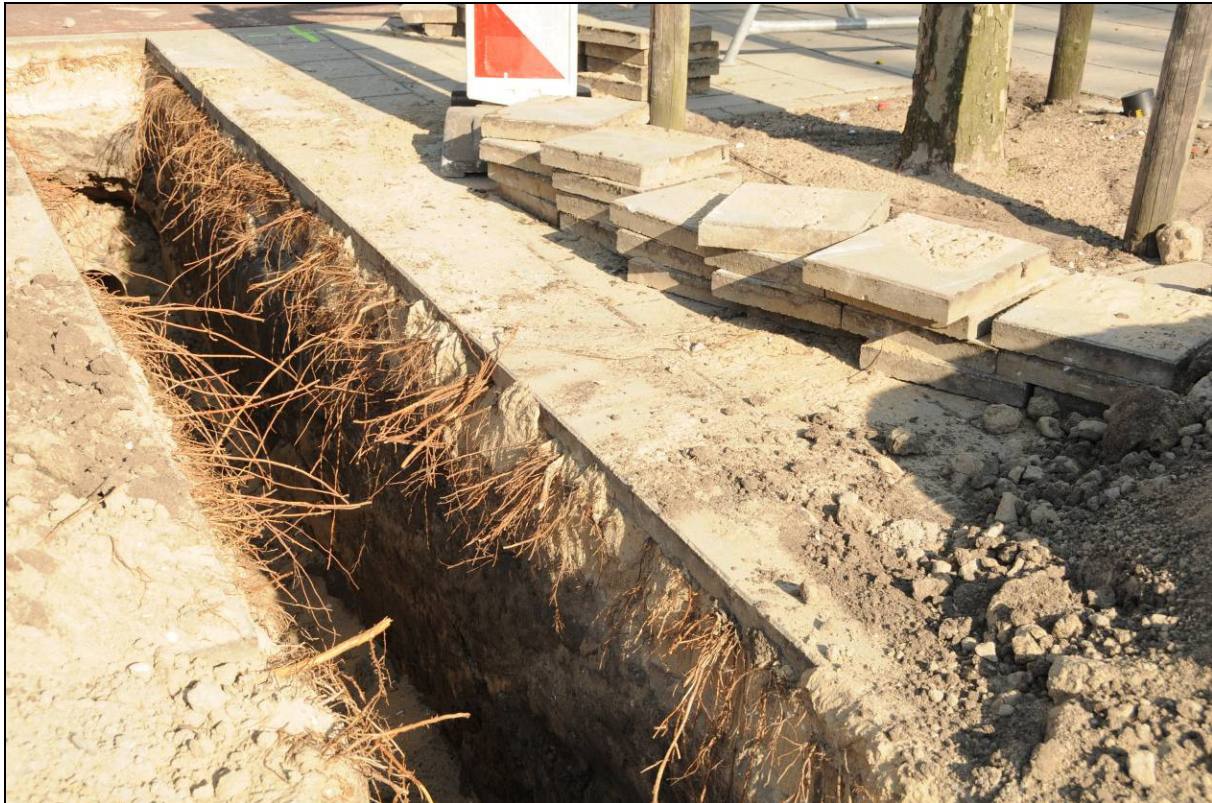
Afb. 19 Boomnummer 43921 met slechts onder de bestrating fijne wortels
