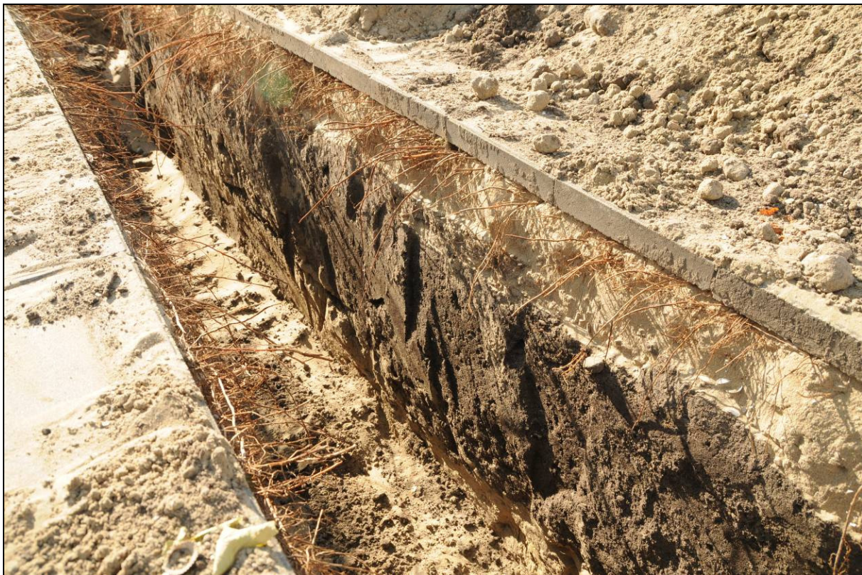
Afb. 4. Fijne beworteling uitsluitend net onder de tegelverharding
