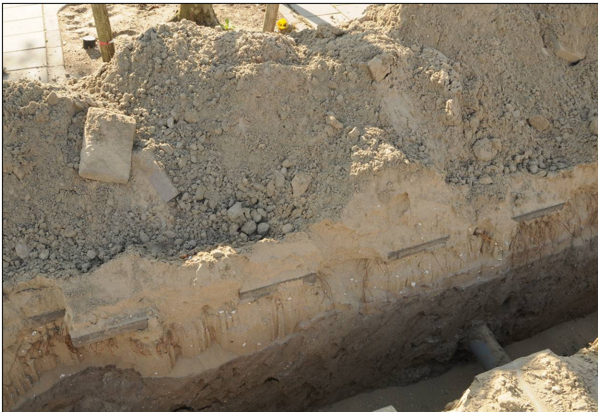
Afb.17 Boomnummer 439710 met slechts onder de bestrating fijne wortels
